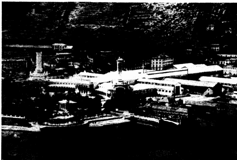
Veduta dei padiglioni della Mostra Voltiana a Como (1899).
